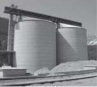
**WOLF-SPÄNESILOS** aus STAHLBETON
