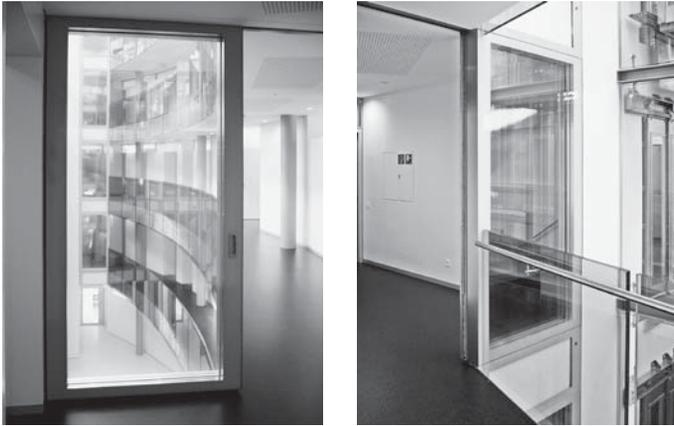
Auch die «Rotonde», Treffpunkt, Veranstaltungsort und Kunstausstellung, wurde mit einem Glasabschluss in der gleichen Konstruktion architektonisch erschlossen. Eine 2-flg. Brandschutztür mit Aluminiumzarge wurde in eine selbsttragende Verglasung mit Brandschutzanforderung EI30 eingebunden. Die Stossfugen wurden lediglich elastisch abgedichtet und erhielten eine Breite von
