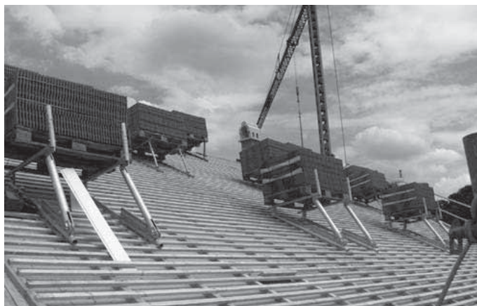
Dachgerüstkonsolen aus dem MATO Z Programm ermöglichen sicheres, effizientes Arbeiten im Steildachbereich.
