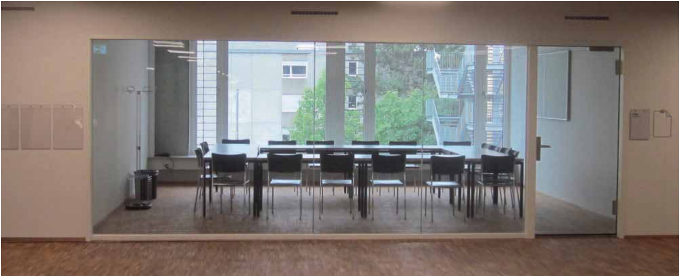
Ei30 Stossfugenverglasung mit Zafag Stahlzargen: 5710 mm lichte Breite und 2135 mm lichte Höhe
