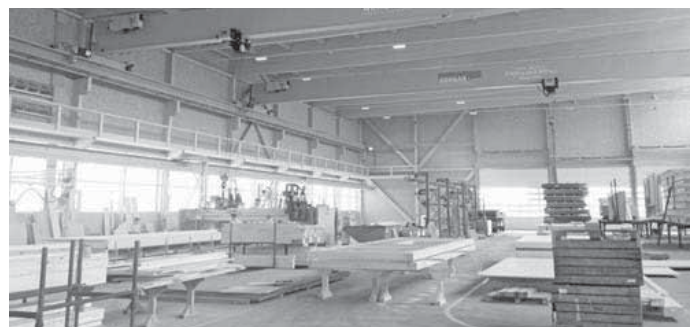
2 Brückenkrane 2 x 6.3 t Traglast.
