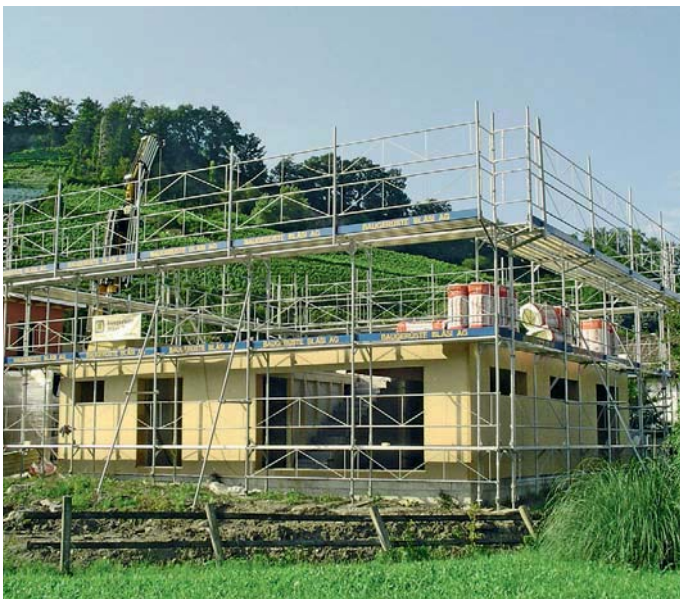
Das MATO 1 Leichtbaugerüst im Einsatz bei einem Elementbau.
