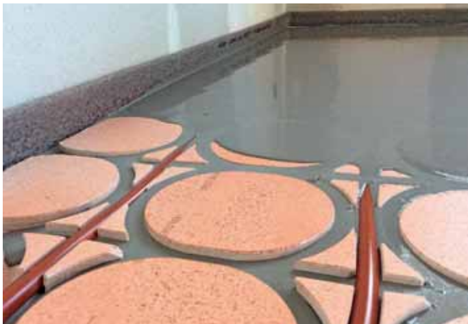
Am Schluss wird der Boden mit der zementären Vergussmasse vergossen. Sie bildet die Grundlage für den späteren Bodenbelag.
