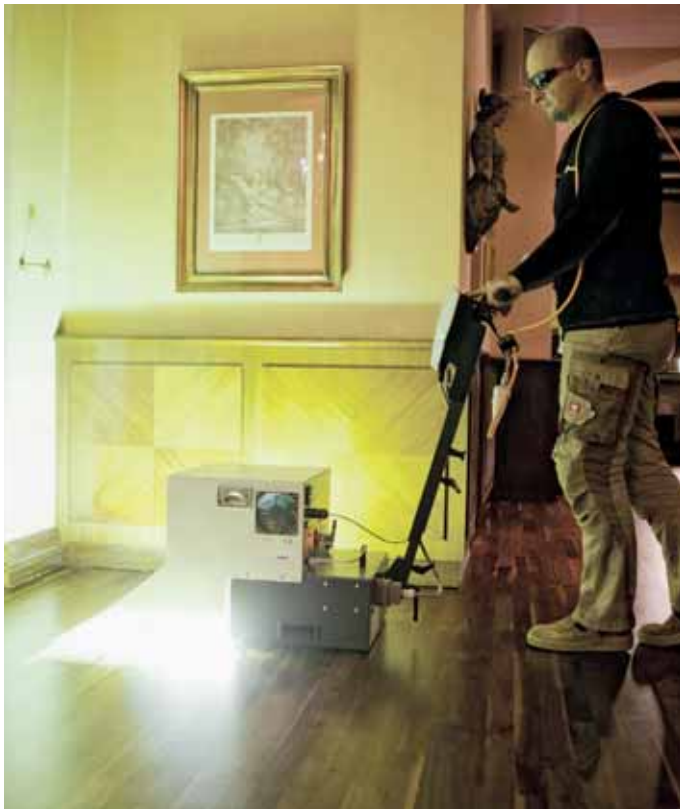
Das Ausleuchten mit dem PALLMANN X-LIGHT MOBIL vernetzt die Beschichtung optimal und macht sie so widerstandsfähig.
