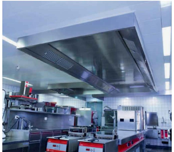
Das flexible AROlight Lichtbandsystem lässt sich auf vielfältige Weise in die AROceiling-Decke integrieren. Als Lichtband mit fertig verdrahteten Beleuchtungskomponenten, die in die stranggepressten Aluminiumkanäle eingesetzt werden, eingebaut zwischen den Abluftkanälen oder in den querliegenden Deckenplatten. Als Abdeckung der Beleuchtung werden zur Entblendung spezielle Acrylglasabdeckungen eingeklippt.
