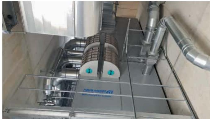
Mit dem Betriebsneubau der Firma von Rohr Holzbau AG in Egerkingen SO ist eine weitere Herausforderung dazugekommen: Eine stationäre «Inhouse»-Absauganlage, die allen Sicherheitsstandards entspricht und in der Funktionalität keine Einbussen hat gegenüber einer stationären Aussenanlage. Mit dem Konzept der flammenlosen Druckentlastungen wird dies erreicht.
