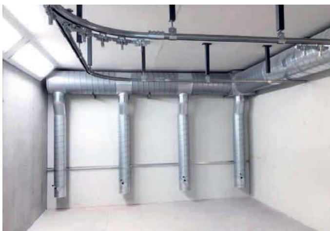
Konzipiert wurde eine grosszügige Lackieranlage mit einer Grundfläche von 7,2 m x 4,0 m – ausgestattet mit einem Gitterrostboden. Die Absaugung erfolgt stirnseitig durch eine Farbspritzwand mit Trockenfilter.
